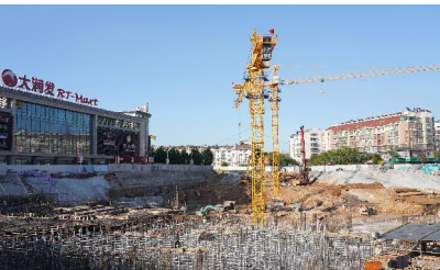
江山老火车站广场(城北广场)及周边地块，将建设一个集旅游商贸、休闲活动、夜间经济业态和住宅于一体的商业休闲综合体。目前项目建设正在加快推进中，预计今年年底广场部分建设可基本成型。图为9月21日，施工方正在对广场部分地下商场进行施工。
