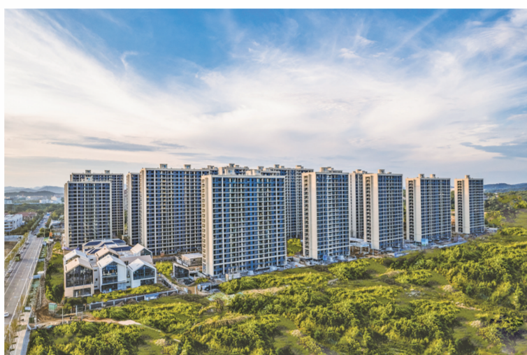
我市首个社会化代建项目城南拆迁安置房公寓楼全面完工
